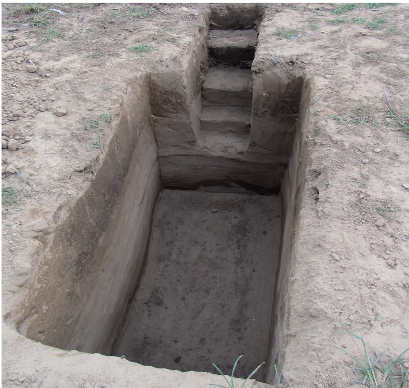
Figura 9. Calicata para la descripción de un perfil de suelo.
